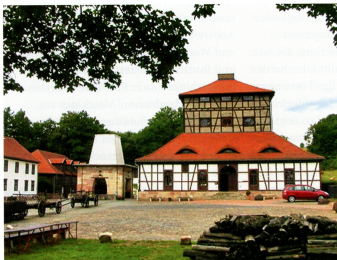
Markenzeichen der Schmalkalder Werkzeugtagung: die ›Neue Hütte‹. Gebaut in einem traditionsreichen Gebiet der Werkzeugherstellung, wurden in der spätklassizistischen Hochofenanlage von 1835 einheimische Eisenerze auf Holzkohlenbasis zu Roheisen verhüttet
